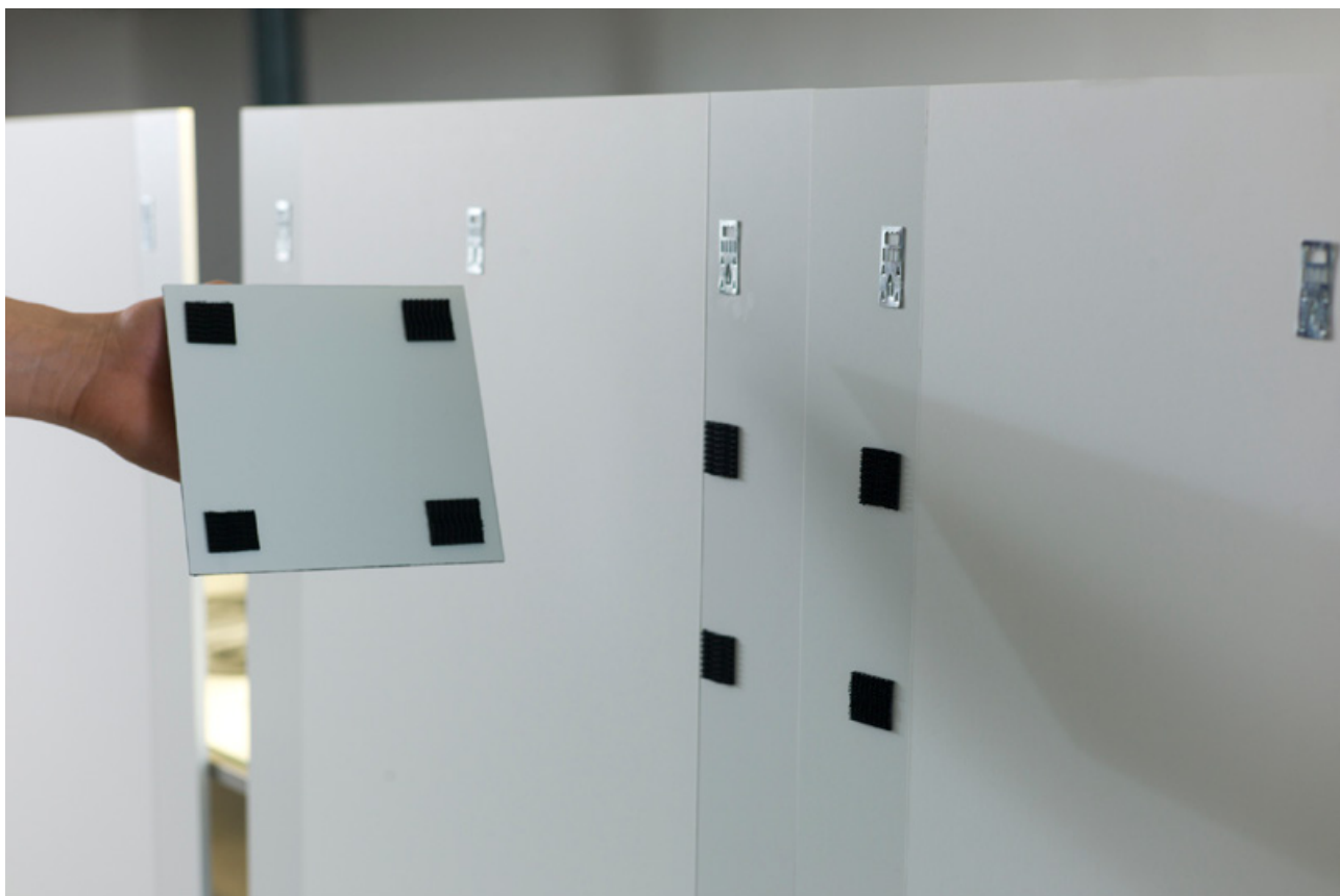
Systém spojení 2 panelů (čtvercový panel).
