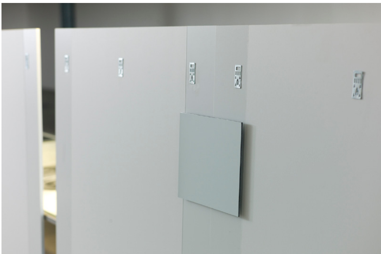
Systém spojení 2 panelů (čtvercový panel).
